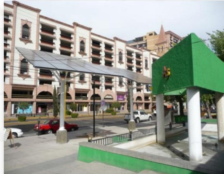
Sistema de Generación Solar Interconectado a la Red de la C.F.E. en Av. López Mateos (9.6 kw potencia y la generación de 20,708.64 kwh/año).
